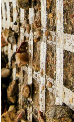
Abb. 1: Verlegte Geogitter aus gedünntem, monolithischem Polyester (PET) oder Polypropylen (PP) kombinieren hohe Stabilität und geringe Kriechneigung mit extremer Robustheit.
