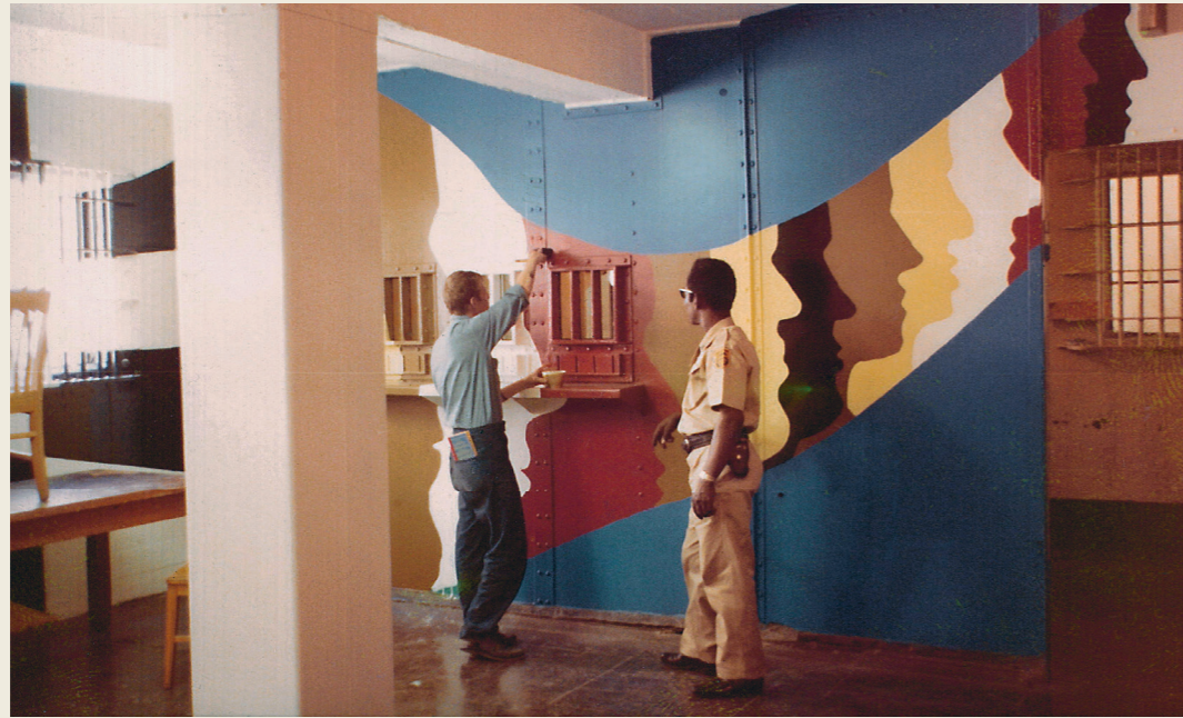
Abb. 6: Renovierung und Umgestaltung des Parish Prison durch Inhaftierte und Metro Link, New Orleans 1970
